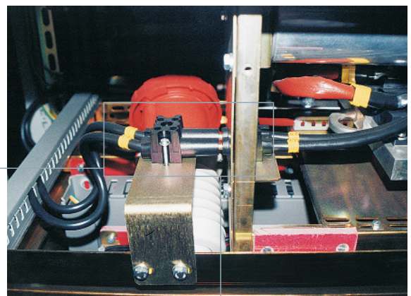
Buchsen- und Steckerleiste-Element P1/100... in einem Einschub
